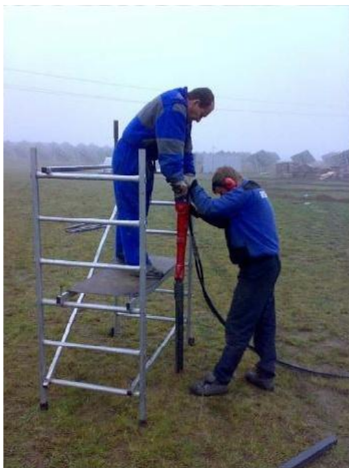
Zde je už montáž kotev do země.
