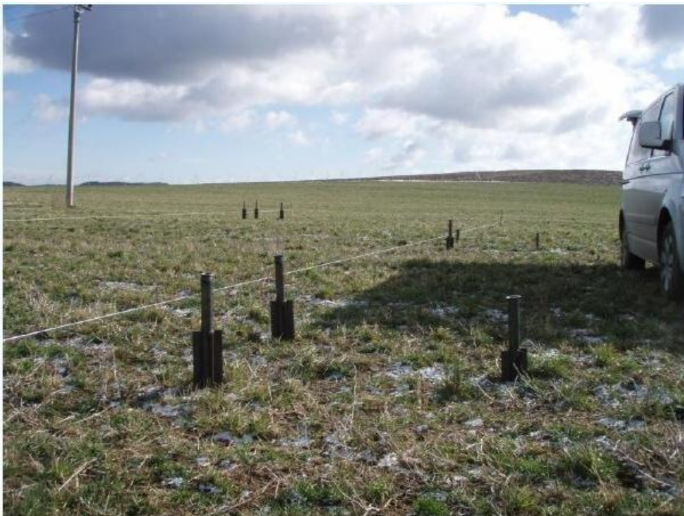
Zkoušení beraněných kotev a rozměření.
