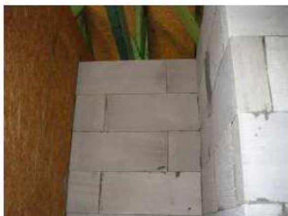
Obrázek 9 Detail svaru hydroizolace
