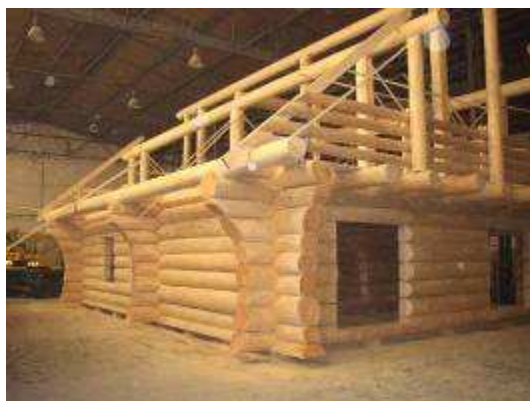
Obrázek 3 Hrubá stavba srubu
