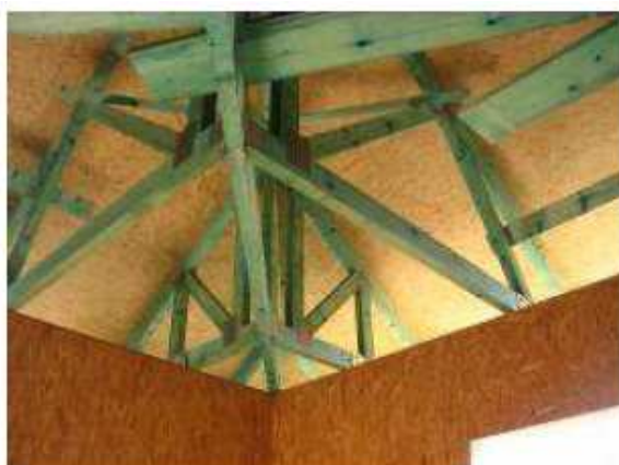
Obrázek 8 Uložení příhradového vazníku na obvodovou stěnu
