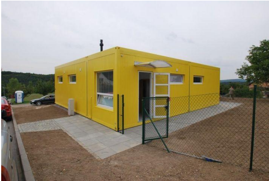
Mateřská školka Oříšek na ulici Drozdí v Ořešíně
