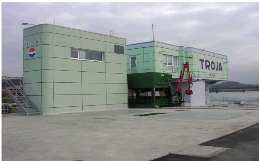
Obr.I:MVE Troja-vlevo budova se schodištěm vedoucím do technických místností -vpravo velín jezu
