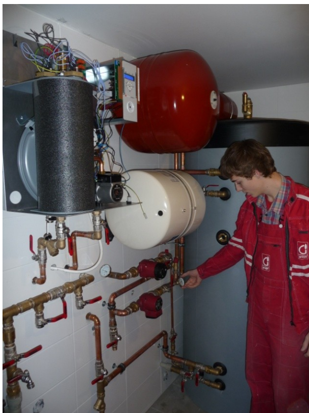
Obr. 4: Instalace zařízení během odborné praxe
