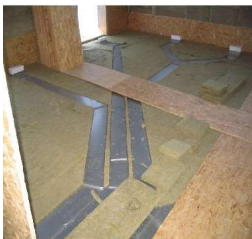
Zapojení potrubí v podlaze
