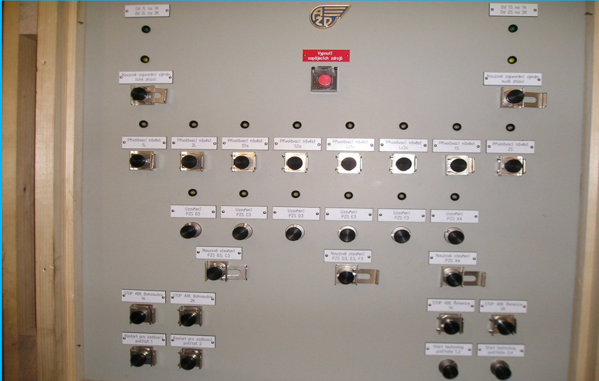
Obrázek č. 19 – Deska nouzových obsluh v ŽST Teplice v Čechách Zdroj: autor
