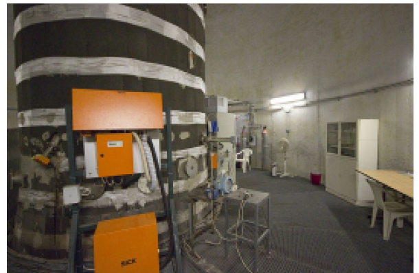
4.4 Prostor komínu mezi opláštěním a vnitřní vložkou, kde probíhá měření emisí
