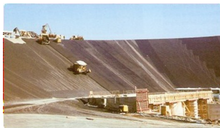
Stavba Horní nádrže
