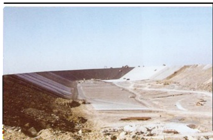
Stavba Horní nádrže
