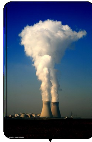
Jaderná elektrárna Dukovany
