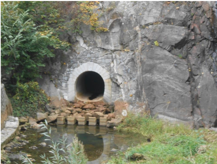
Nevyužívaná spodní výpust'
