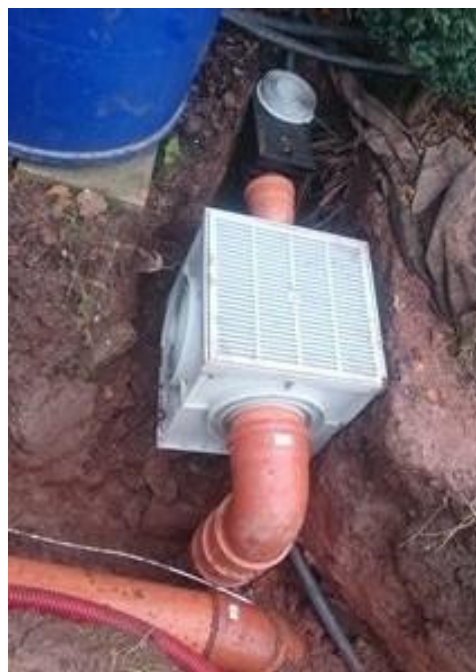
Obr. 6 – kanalizační šachta
