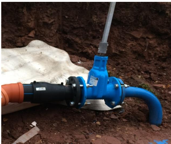
Obr. 7 – uzavírací armatura
