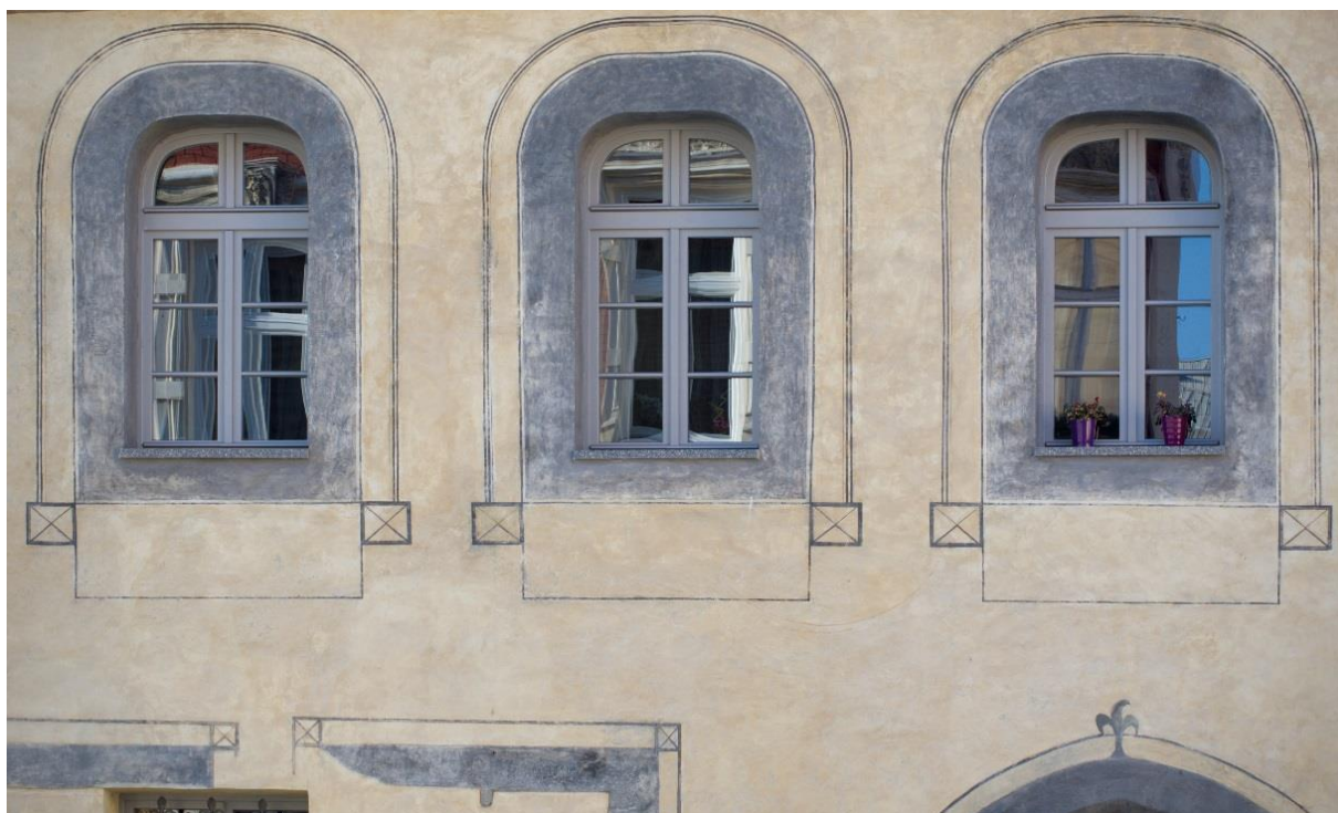
Obr. 66 Detail průčelí domu čp. 163, obnovená gotická podoba fasády z uliční strany
