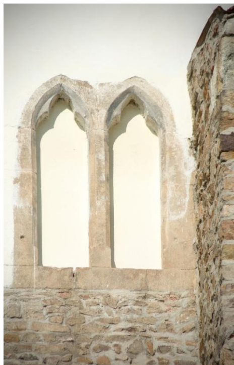
Obr. 27 Fotografie zachovaného gotického sruženého okna na hradě
