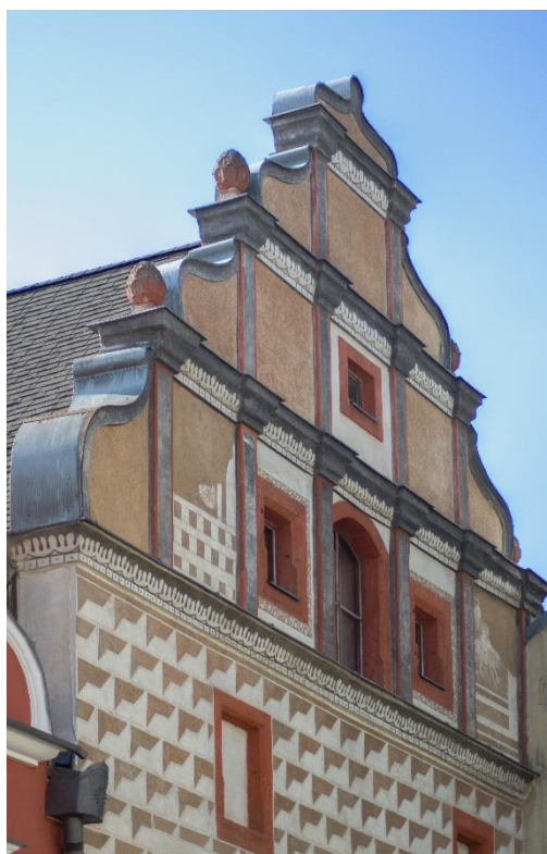
Obr. 56 Fotografie štítu domu čp. 18
