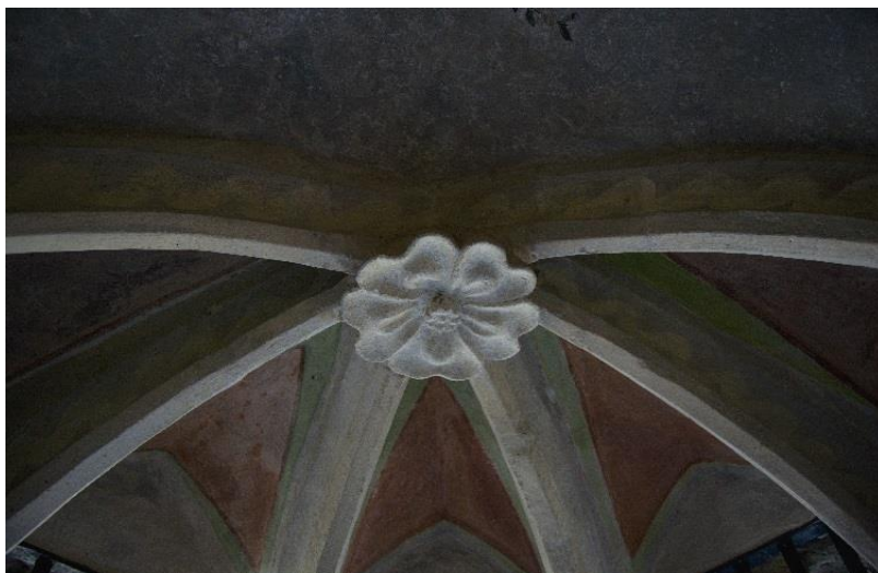
Obr. 31 Žebrové zaklenutí arkýře, interiér radniční věže
