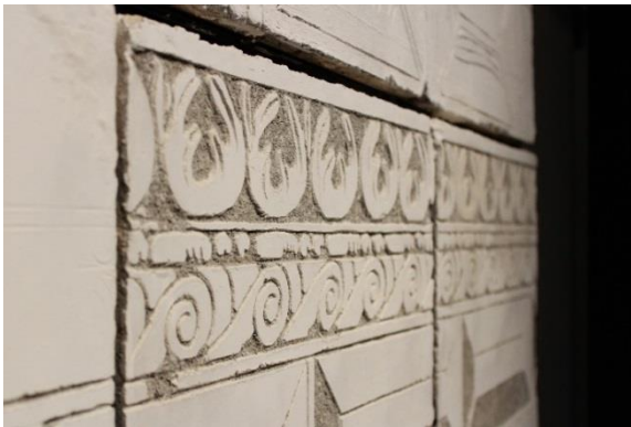
Obr. 77 Detail sgrafitové omítky
