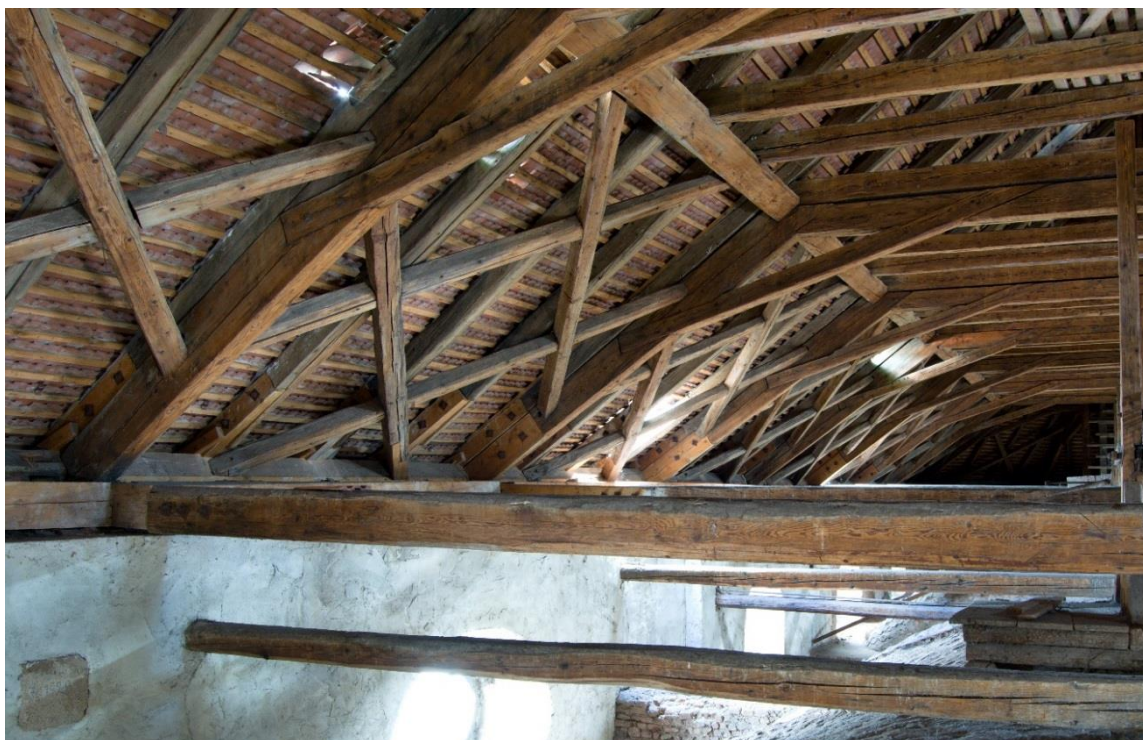
Obr. 42 Fotografie půdního prostoru kostela, konstrukce krovu, odkrytý rub zaklenutí
