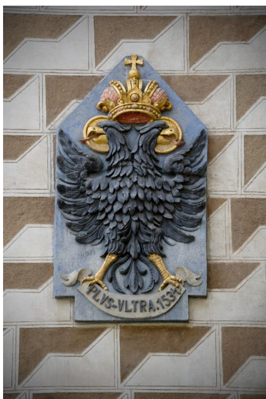
Obr. 55 Detailní fotografie erbu na uliční stěně domu čp. 18, na fotografii je patrná sgrafitová omítka
