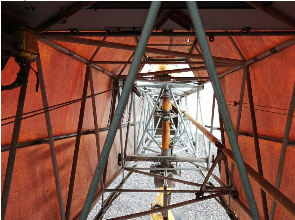
Obr. 3: Konstrukce v zadní části trupu
